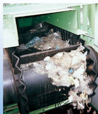
廃プラスチック搬送
